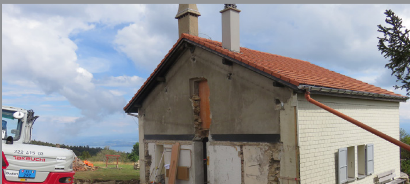
Démolition de la partie bucher - toilettes
