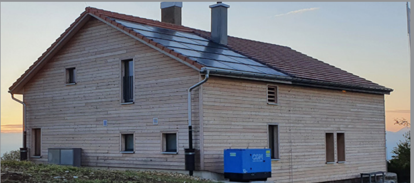
Construction de l'annexe nord avec ses panneaux solaires et nouvelle façade ouest
